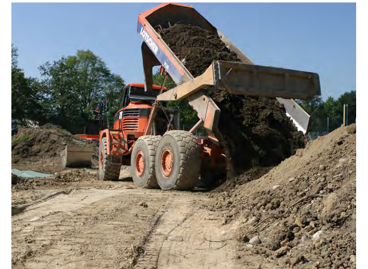
Zwischenlagerung von unverschmutztem Aushubmaterial für die Rekultivierung
