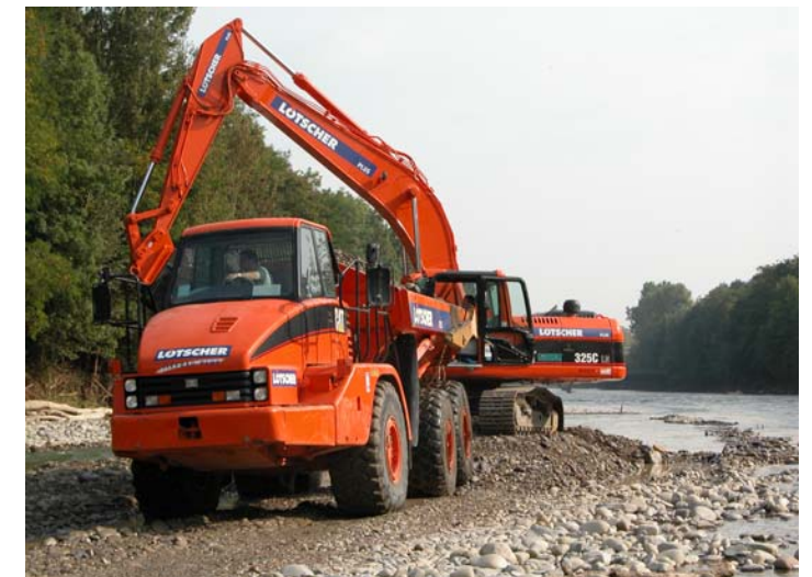
Ausbaggern eines Flussbettes zur Eindämmung von Hochwasser
