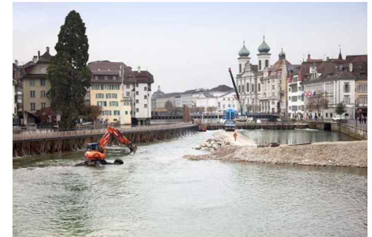
Ausbaggern eines Flussbettes zur Eindämmung von Hochwasser
