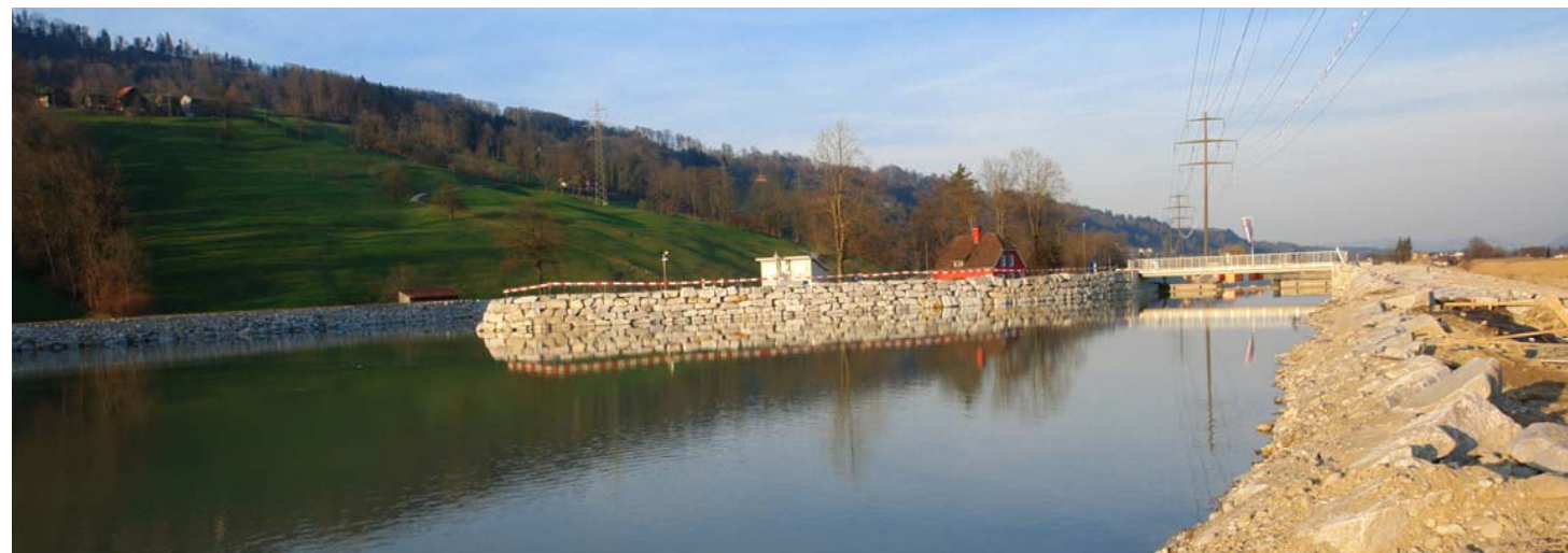
Anlegen eines Sees mit Natursteinmauer als Abschluss
