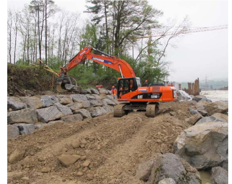
Erstellen von Buhnen als Massnahmen zur Aufwertung des Lebensraums für Fische
