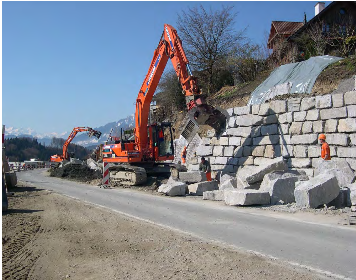
Neue Lösungen mit Natursteinmauern parallel zum Strassenverkehr gebaut
