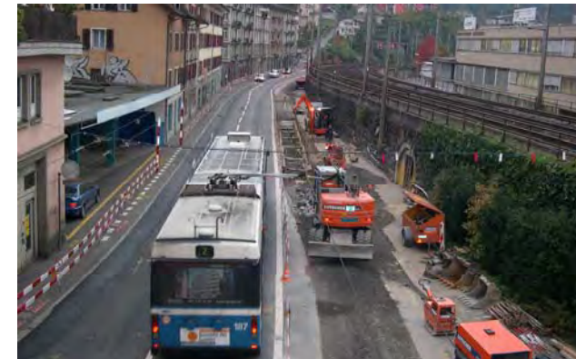
Baselstrasse Luzern, Kanalisationsbau unter hohem Verkehrsaufkommen
