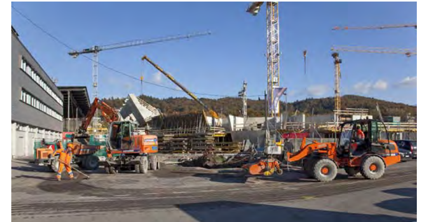
Umgebung Sportarena Allmend (Werkleitungen, Kanalisation, Vorplätze etc.)
