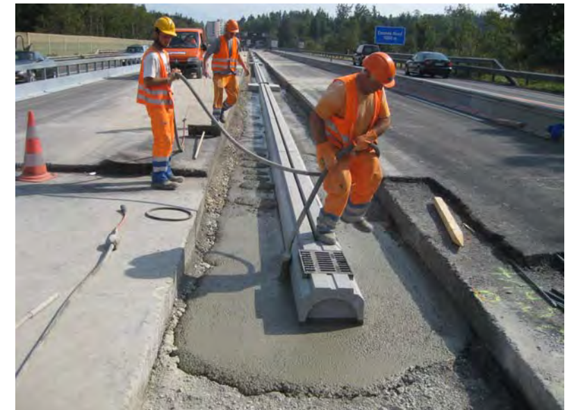
Versetzen von Fahrbahnmittellinie
