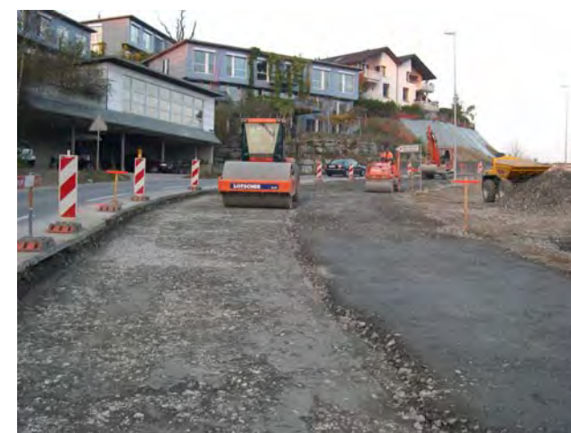
Verdichtung Kiessand mit Walze
