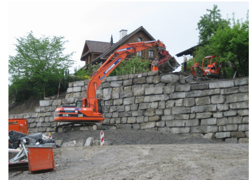
Granitsteinmauer als Stützkörper im Strassenbau
