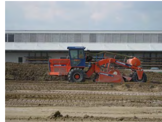
Bodenverbesserung Stabilisierung
