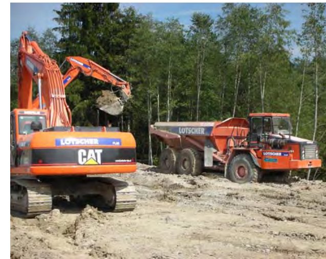
Zwischentransport bei Erdarbeiten mit Grossdumper
