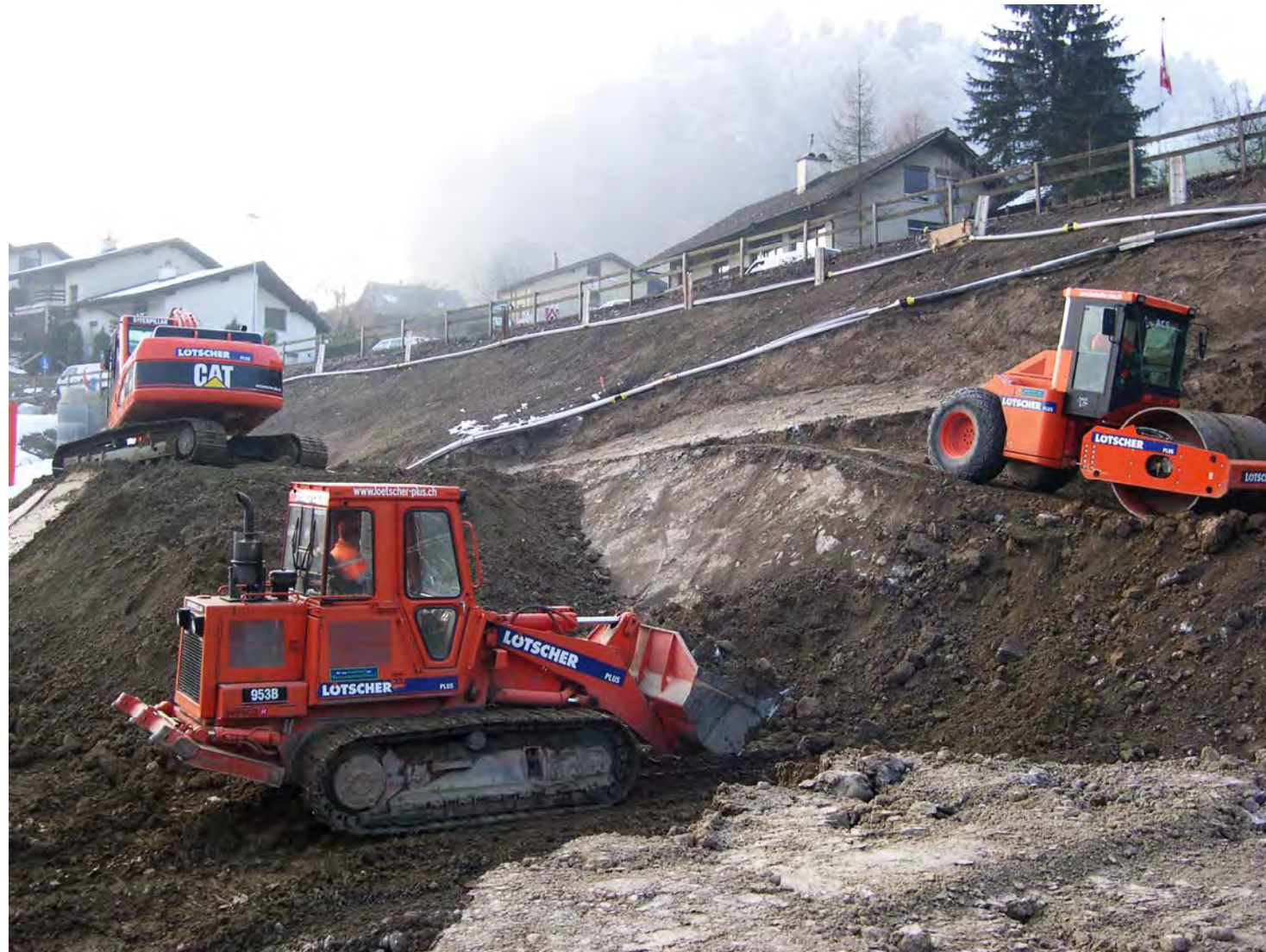
Aufbau eines Damms zur Verbreiterung des bestehenden Strassenkörpers
