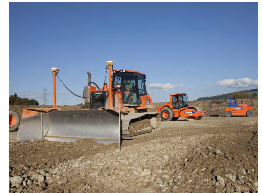
Einbringen Planum mit satellitengesteuerter Planierraupe
