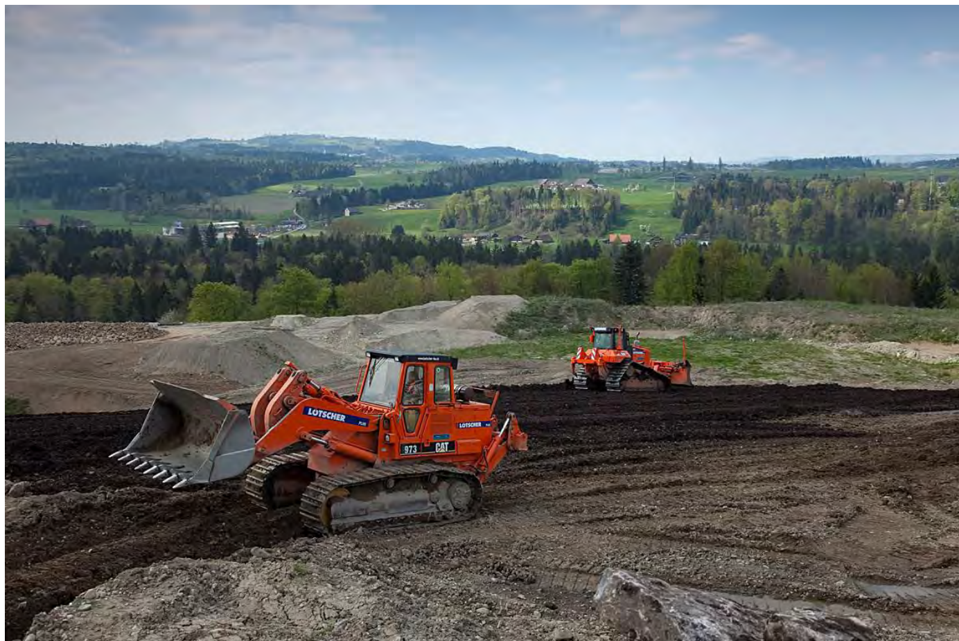
Einbau Deponiematerial
