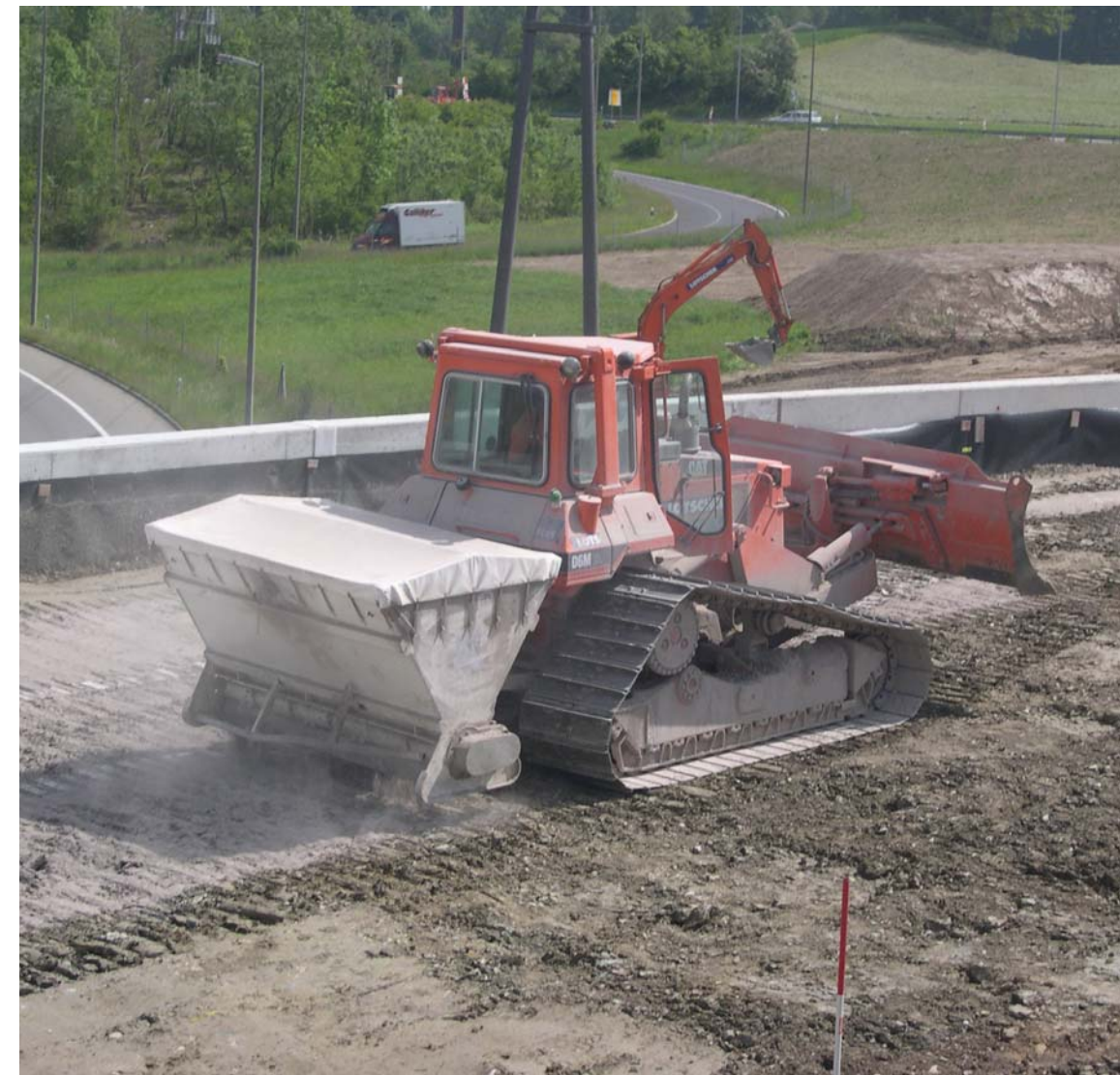
Dosierbares Streugerät verteilt das Bindemittel auf dem Planum
