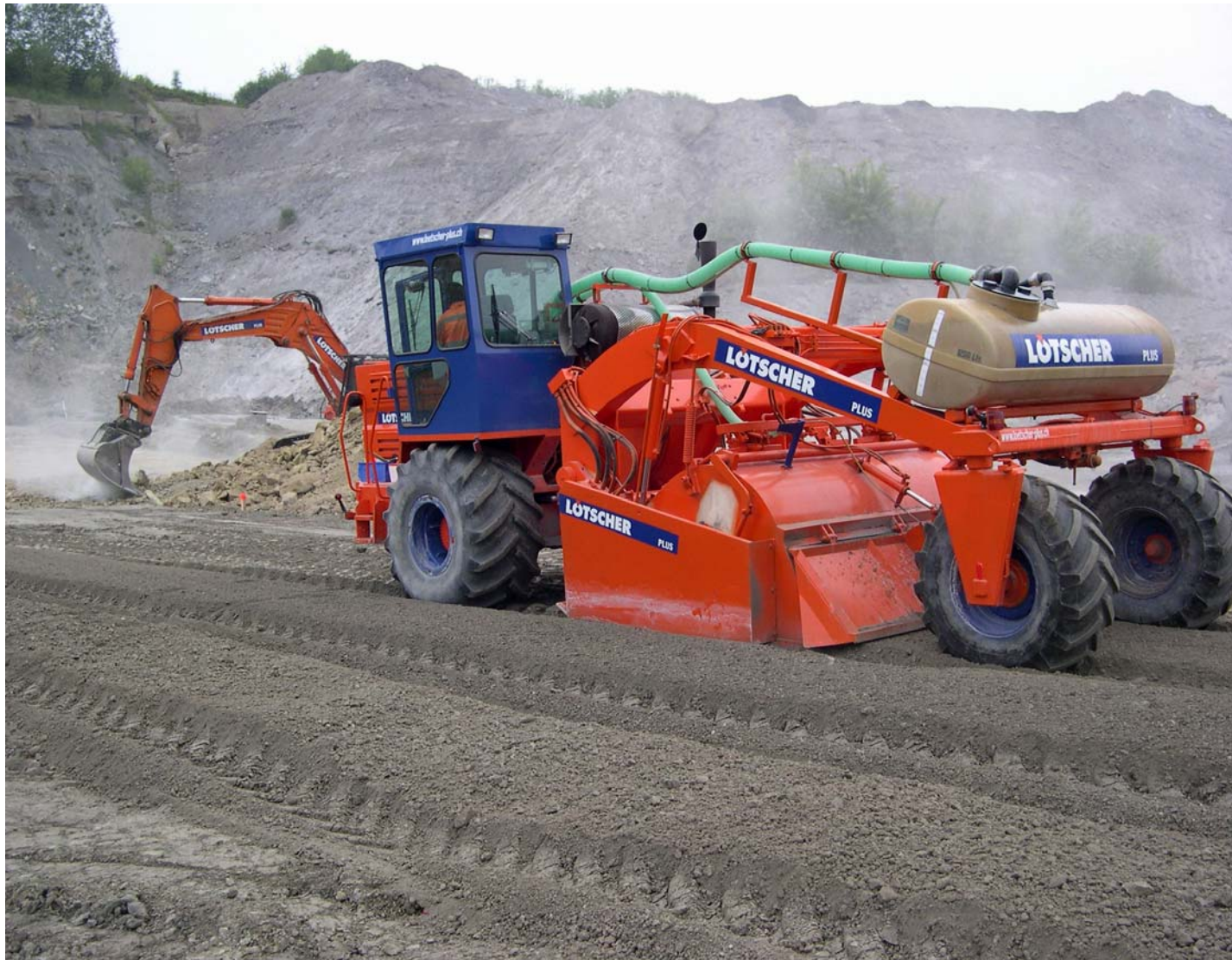
Selbstfahrende Bodenfräse RACO 250 mit Einsprühanlage
