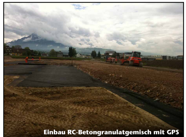
Stabilisierung Untergrund in Kolonne: Dozer (GPS-gesteuert), Bindemittelverteiler, Stabilisierer
