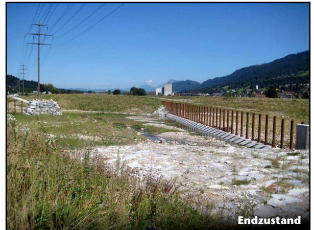
Versetzen von Blocksteinen als Uferschutz
